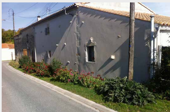
Un exemple de trottoir fleuri et entretenu par une virsonnaise
