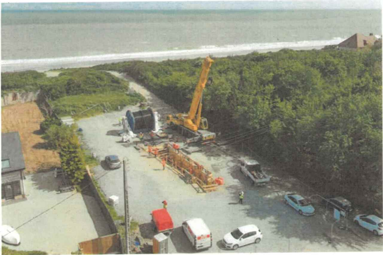
Figure 1: Exemple d'une chambre de jonction d'atterrage avant comblement (Interconnexion France-Angleterre IFA2) (source : RTE)
