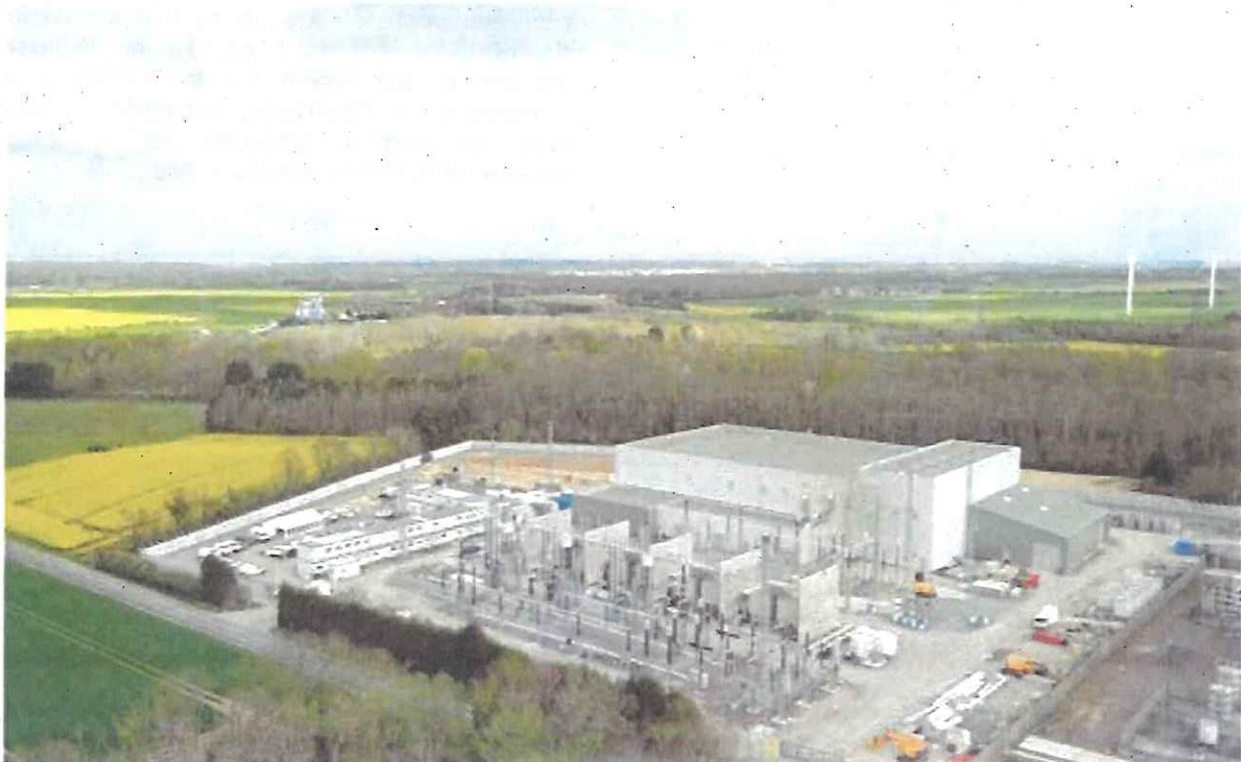
Figure 5: Exemple d'une station de conversion 320 kV continu / 400 kV alternatif (source: RTE)
