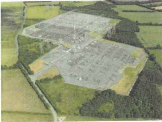
Figure 6: Poste de 400 kV de Granzay (Deux-Sèvres) (source: RTE)
