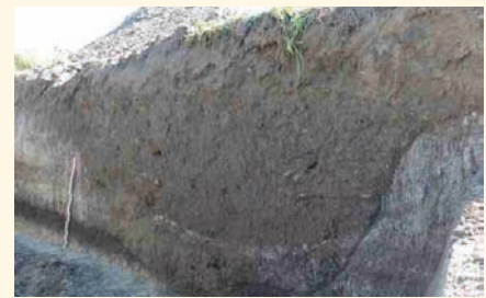
Fig. 8 : un des grands fossés drainant vu en coupe (photo C. Vacher)
